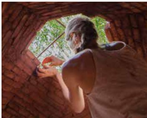
*Durch geschicktes Einpassen der Steine lassen sich sogar Rundbögen und Kuppeldächer erstellen.*
